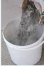
Harcın suya eklenmesi
