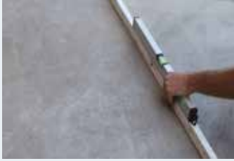
Yüzeyin düzgünlüğünün kontrol edilmesi
