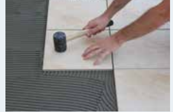
Çekiçle vurulup seviyelendirilmesi
