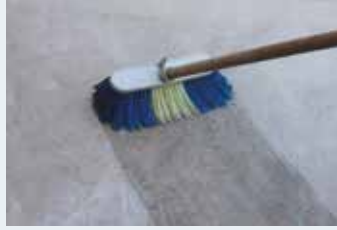
Yüzeyin temizlenip nemlendirilmesi
