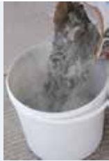
Harcın suya eklenmesi
