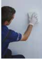
Nemli sünger ile derz yüzeyinin düzeltilmesi
