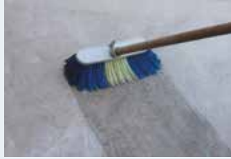
Yüzeyin temizlenip nemlendirilmesi
