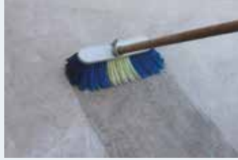
Yüzeyin temizlenip nemlendirilmesi
