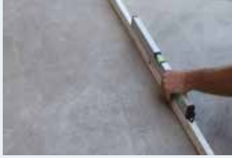
Yüzeyin düzgünlüğünün kontrol edilmesi
