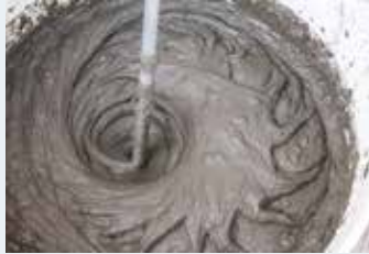
Karıştırıcı ile karıştırma
