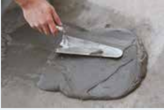
Harcın mala yardımı ile yüzeye aktarılması
