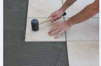
Çekiçle vurulup seviyelendirilmesi
