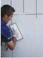
Dolgu malzemesinin duvara uygulanması
