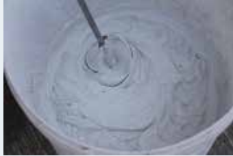
Karıştırıcı ile karıştırma
