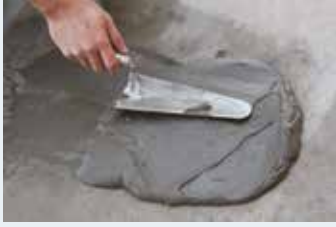
Harcın mala yardımı ile yüzeye aktarılması
