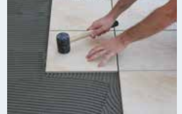
Çekiçle vurulup seviyelendirilmesi
