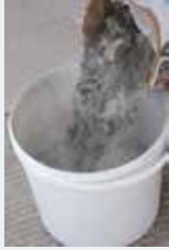
Harcın suya eklenmesi
