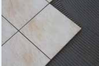
Seramiğin yerleştirilmesi
