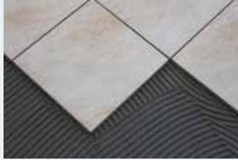
Seramiğin yerleştirilmesi
