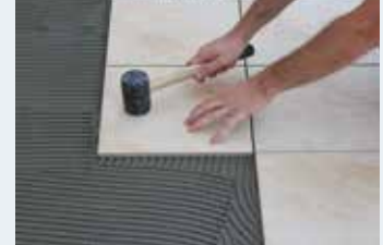
Çekiçle vurulup seviyelendirilmesi
