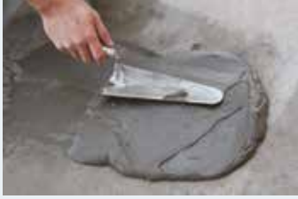
Harcın mala yardımı ile yüzeye aktarılması
