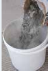
Harcın suya eklenmesi
