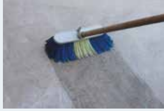
Yüzeyin temizlenip nemlendirilmesi
