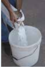
Harcın suya eklenmesi
