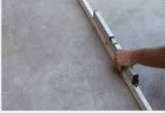
Yüzeyin düzgünlüğünün kontrol edilmesi
