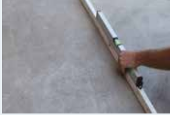
Yüzeyin düzgünlüğünün kontrol edilmesi
