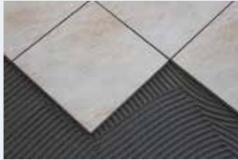
Seramiğin yerleştirilmesi
