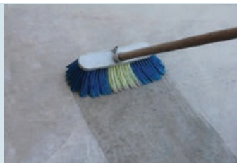
Yüzeyin temizlenip nemlendirilmesi
