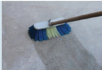
Yüzeyin temizlenip nemlendirilmesi
