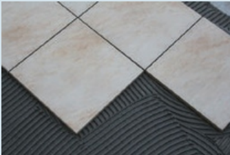
Seramiğin yerleştirilmesi
