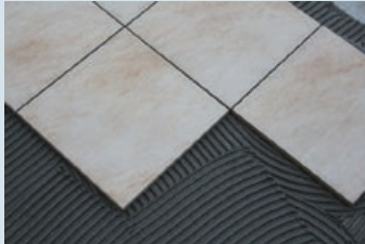
Seramiğin yerleştirilmesi
