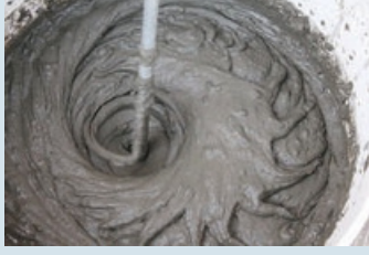
Karıştırıcı ile karıştırma
