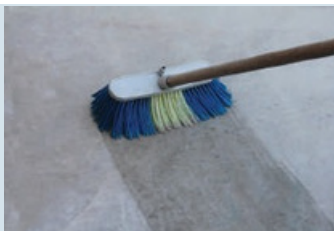
Yüzey temizlenip kuru olmalı
