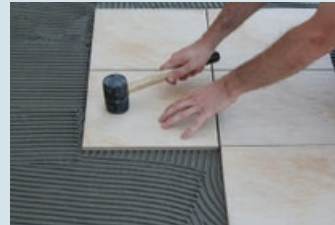
Çekiçle vurulup seviyelendirilmesi
