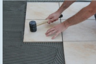
Çekiçle vurulup seviyelendirilmesi
