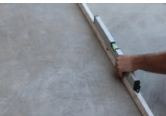
Yüzey düzgünlüğünün kontrol edilmesi
