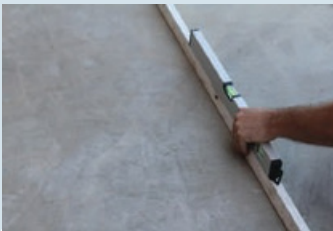
Yüzey düzgünlüğünün kontrol edilmesi
