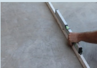
Yüzey düzgünlüğünün kontrol edilmesi
