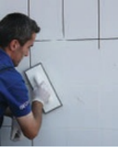
Dolgu malzemesinin duvara uygulanması
