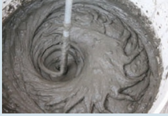
Karıştırıcı ile karıştırma
