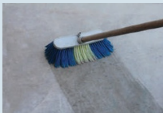
Yüzeyin temizlenip nemlendirilmesi
