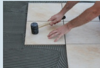
Çekiçe vurulup seviyelendirilmesi
