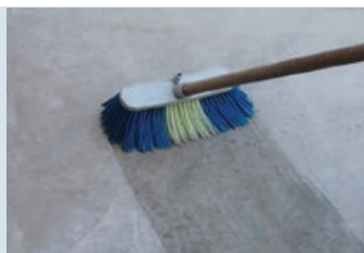
Yüzeyin temizlenip nemlendirilmesi
