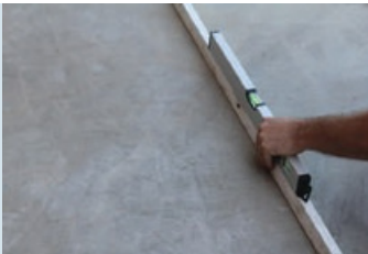
Yüzey düzgünlüğünün kontrol edilmesi
