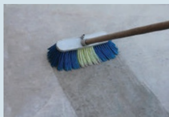
Yüzeyin temizlenip nemlendirilmesi
