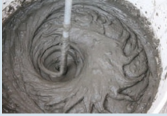
Karıştırıcı ile karıştırma
