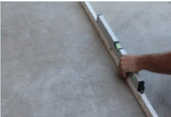
Yüzey düzgünlüğünün kontrol edilmesi
