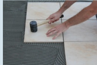
Çekiçle vurulup seviyelendirilmesi
