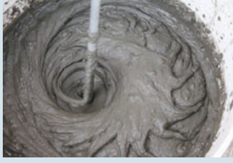
Karıştırıcı ile karıştırma
