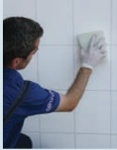
Nemli sünger ile derz yüzeyinin düzeltilmesi
