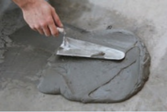
Harç mala yardımı ile yüzeye aktarılması
