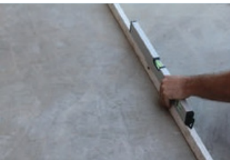
Yüzey düzgünlüğünün kontrol edilmesi
