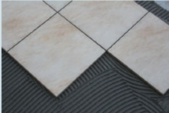
Seramiğin yerleştirilmesi
