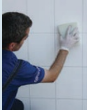
Nemli sünger ile derz yüzeyinin düzeltilmesi
