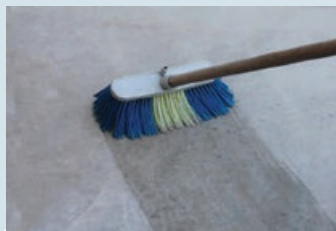
Yüzeyin temizlenip nemlendirilmesi
