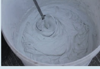
Karıştırıcı ile karıştırma
