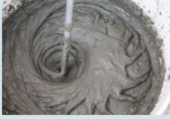
Karıştırıcı ile karıştırma
