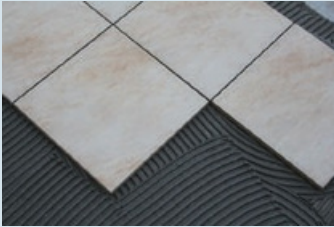
Seramiğin yerleştirilmesi
