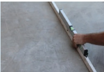
Yüzey düzgünlüğünün kontrol edilmesi
