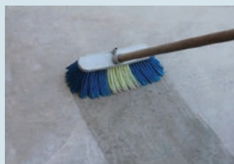
Yüzeyin temizlenip nemlendirilmesi
