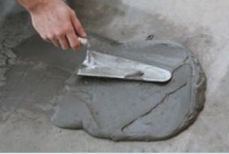
Harcın mala yardımı ile yüzeye aktarılması
