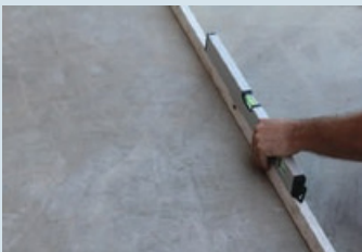
Yüzey düzgünlüğünün kontrol edilmesi
