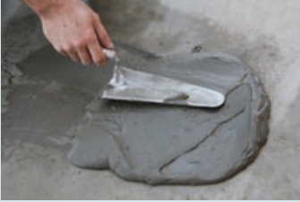
Harcın mala yardımı ile yüzeye aktarılması
