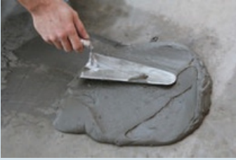
Harcın mala yardımı ile yüzeye aktarılması
