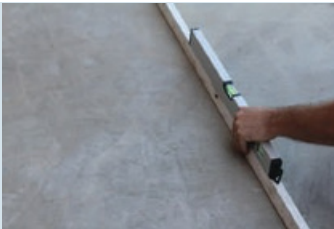
Yüzey düzgünlüğünün kontrol edilmesi
