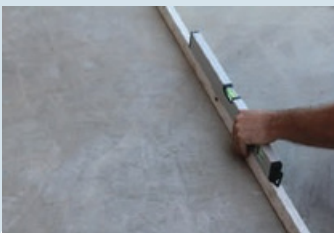
Yüzey düzgünlüğünün kontrol edilmesi
