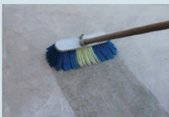
Yüzeyin temizlenip nemlendirilmesi
