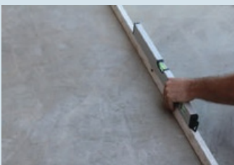
Yüzey düzgünlüğünün kontrol edilmesi
