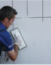
Dolgu malzemesinin duvara uygulanması
