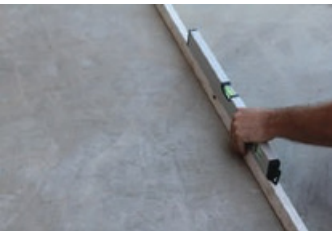
Yüzey düzgünlüğünün kontrol edilmesi
