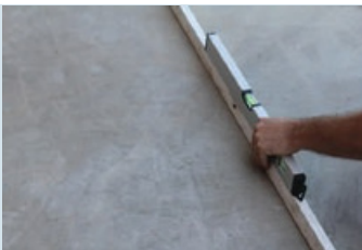
Yüzey düzgünlüğünün kontrol edilmesi
