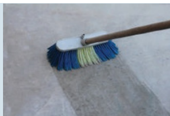
Yüzeyin temizlenip nemlendirilmesi
