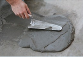
Harcın mala yardımı ile yüzeye aktarılması
