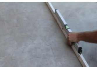
Yüzey düzgünlüğünün kontrol edilmesi
