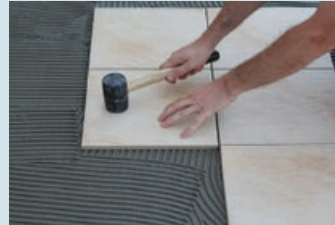
Çekiçle vurulup seviyelendirilmesi
