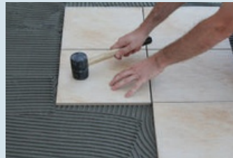
Çekiçe vurulup seviyelendirilmesi
