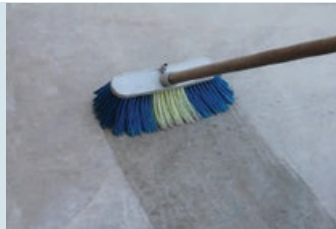
Yüzeyin temizlenip nemlendirilmesi
