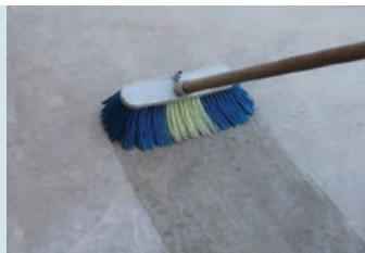
Yüzeyin temizlenip nemlendirilmesi
