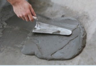
Harcın mala yardımı ile yüzeye aktarılması
