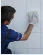
Nemli sünger ile derz yüzeyinin düzeltilmesi
