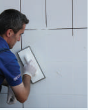
Dolgu malzemesinin duvara uygulanması
