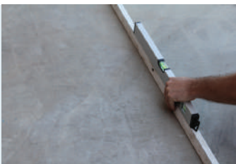
Yüzeyin düzgünlüğünün kontrol edilmesi
