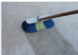
Yüzeyin temizlenip nemlendirilmesi
