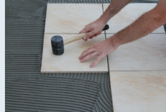
Çekiçe vurulup seviyelendirilmesi
