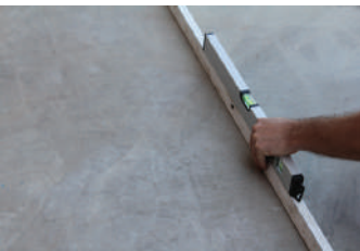
Yüzeyin düzgünlüğünün kontrol edilmesi
