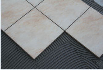
Seramiğin yerleştirilmesi
