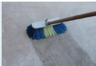
Yüzeyin temizlenip nemlendirilmesi
