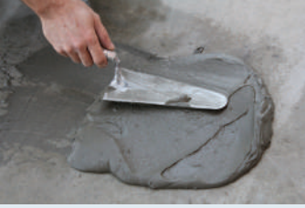
Harçın mala yardımı ile yüzeye aktarılması
